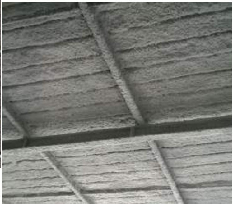
Cellulose Fiber Insulation : cocok untuk meredam panas & sound-control pada atap metal & slab beton
